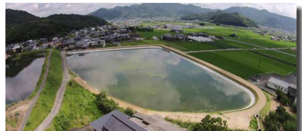
松木池堤体工事（矢掛町）
