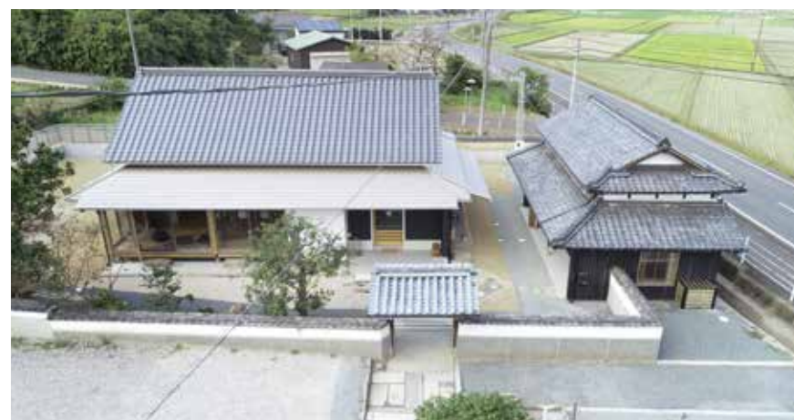
矢掛町 里山田サテライトオフィス整備工事
