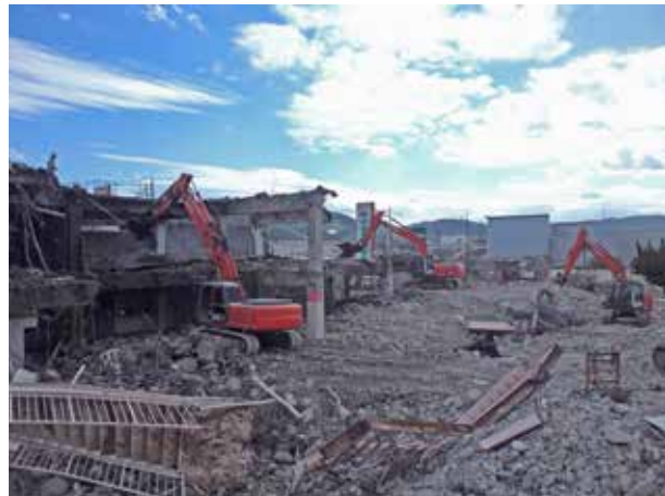
⑤外装解体
