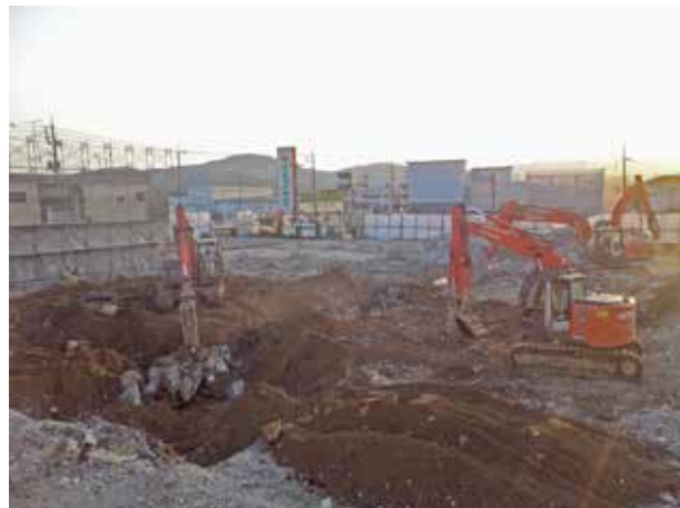
⑥基礎解体
