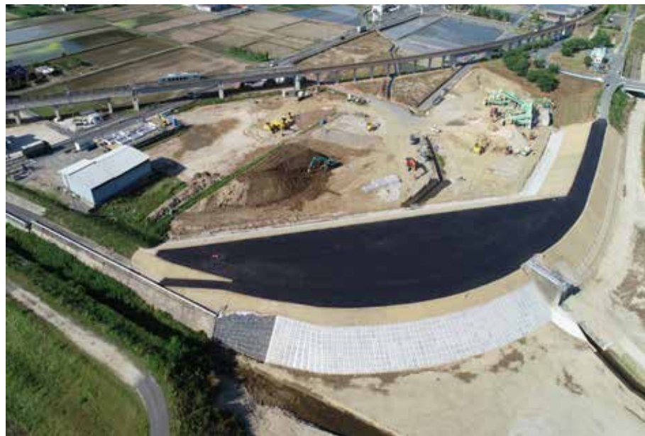
小田川災害復旧工事
