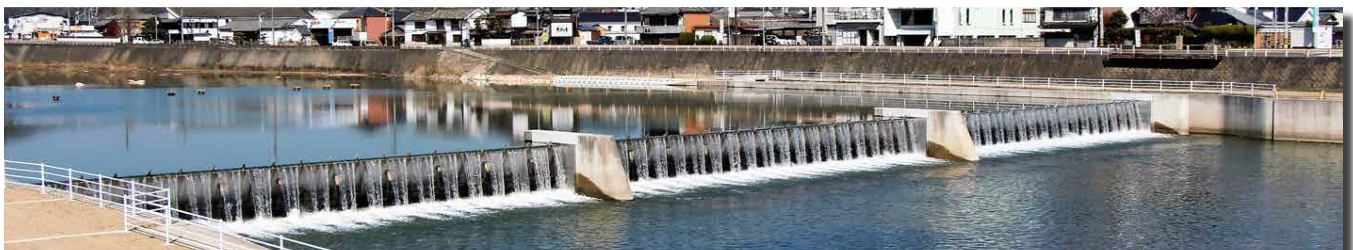
小田川公共河川工事（矢掛町）
