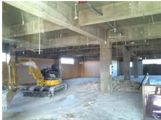
③内装解体
