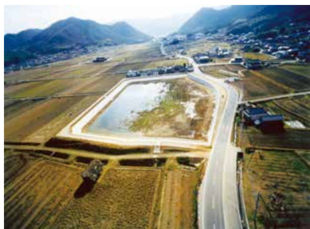
五反田池堤体工事（矢掛町）
