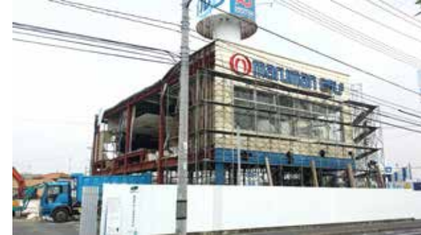
③外装解体
