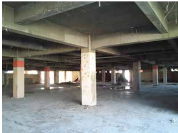
④内装解体
