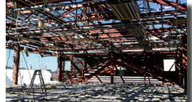
③外装解体
